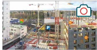
Etupihahankkeen töiden etenemistä voi seurata sairaalan katolle asennetun kamerasivun välityksellä Taysin ja SRV:n internet-sivuilla.
