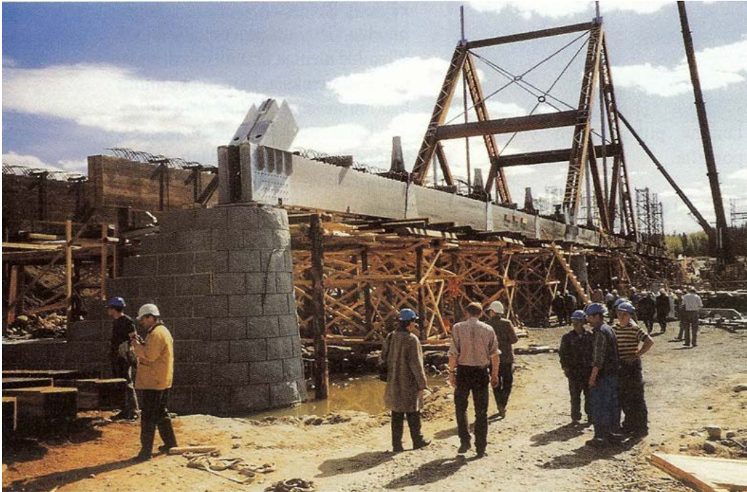
Kuva 19: Vihantasalmen siltatyömaata (kuva Rakennusinsinööri-lehdestä)
