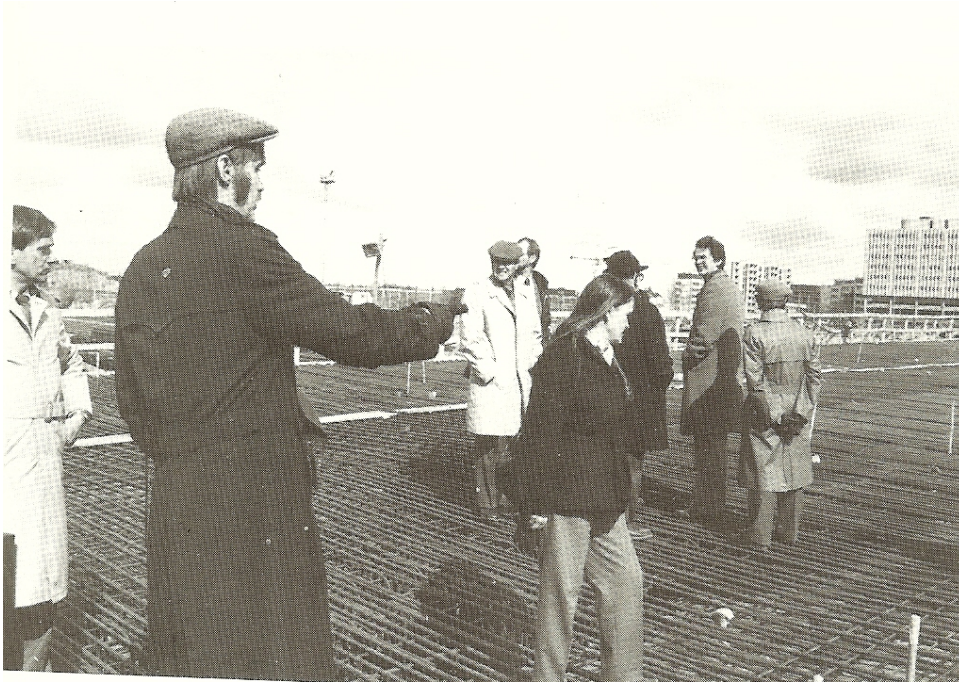
Kuva 3: Osaottajia Pasilan siltatyömaalla, etualalla Torsten Lunabba.
