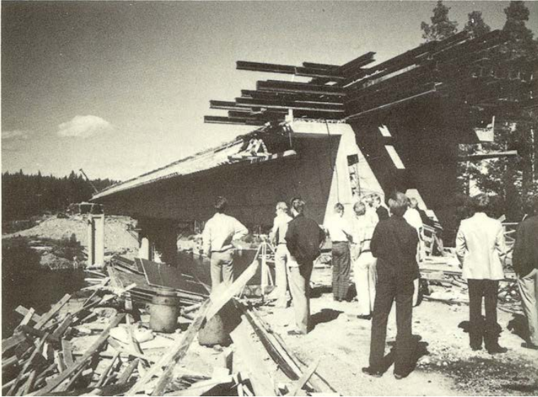
Kuva 13: Vuoksensalmen sillanpuolisko paikoilleen siirrettynä, vastapainona rautaromua
