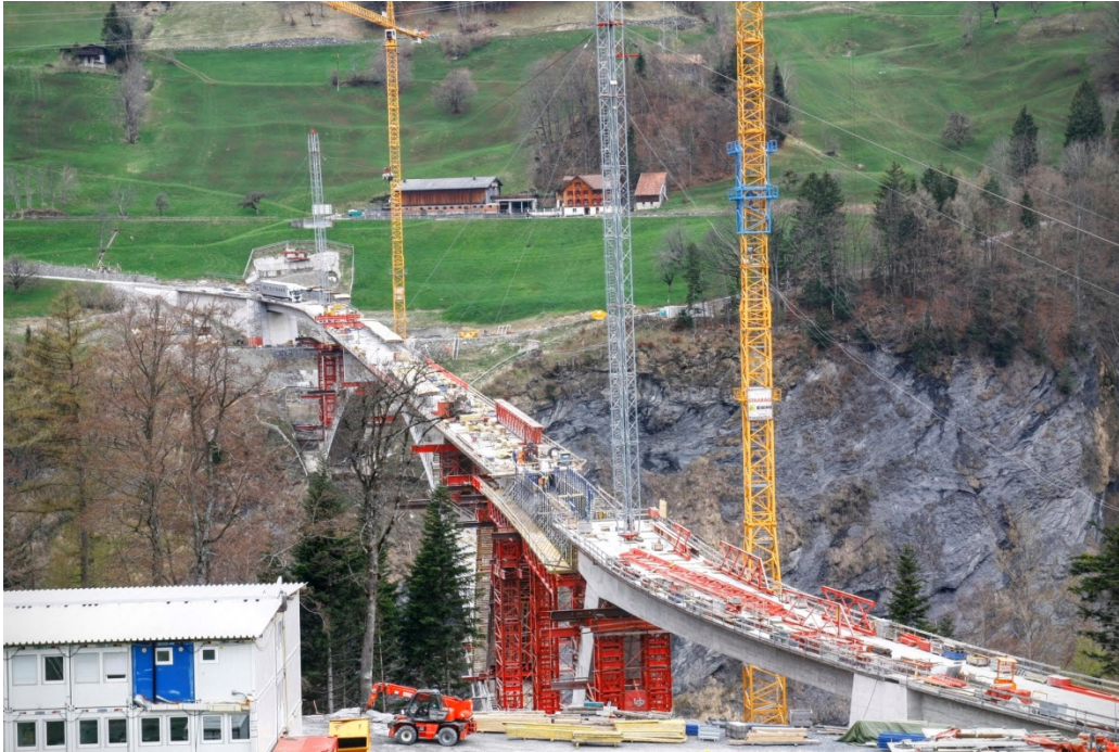
Kuva 26: Tamina-sillan työmaata (kuva: Mikko Hyyrynen)
