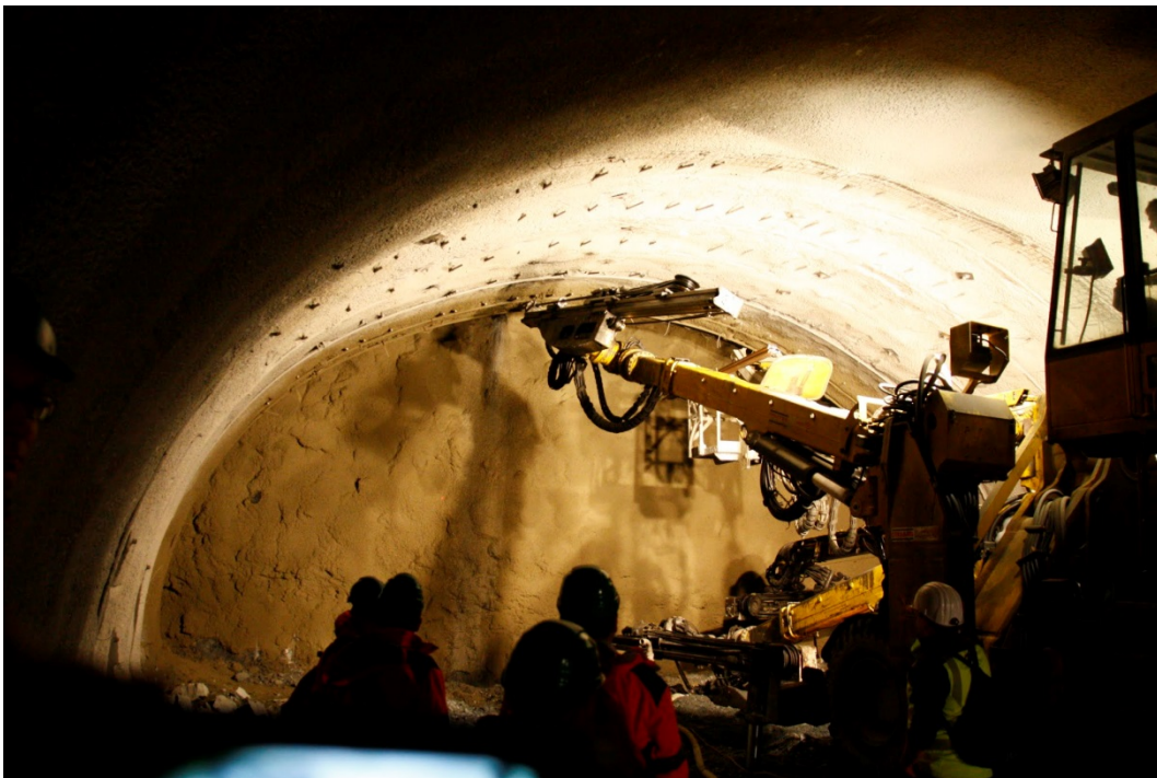
Kuva 29: Porausrobotti työssään Brennerin tunnelissa (kuva: Mikko Hyyrynen)
