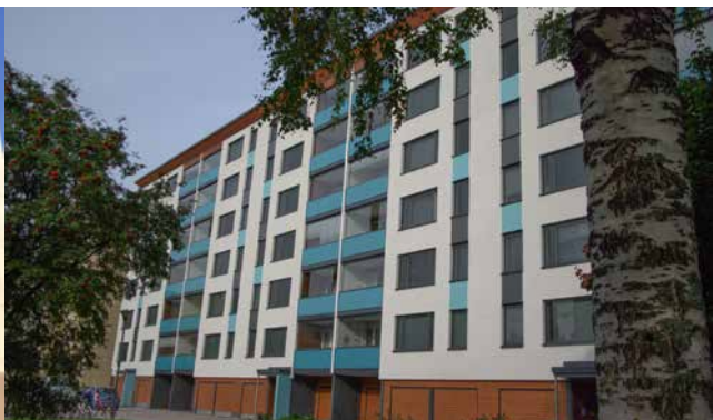
Rakennuksen julkisivu etelään perusparannuksen jälkeen. Kaivokadun kohde tuli kolmanneksi vuoden 2017 julkisivuremonttikilpailussa.
