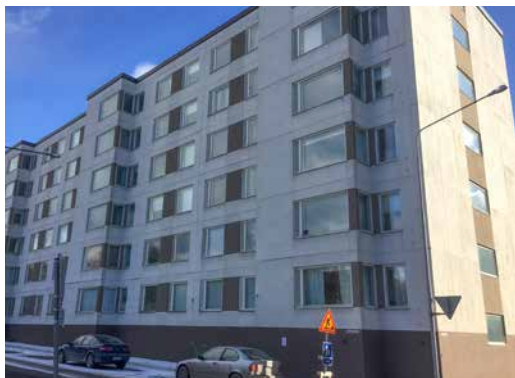
Rakennuksen julkisivu etelään ennen perusparannusta.
