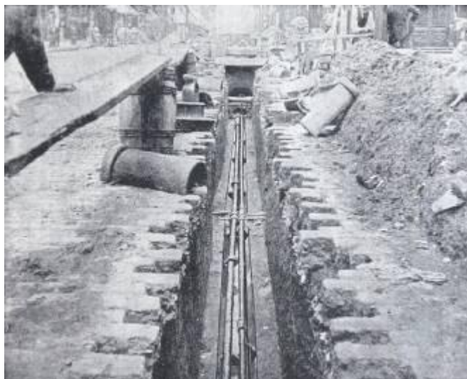
Kaukojäähdytysputkien asennusta New Yorkissa 1891. (Am)
