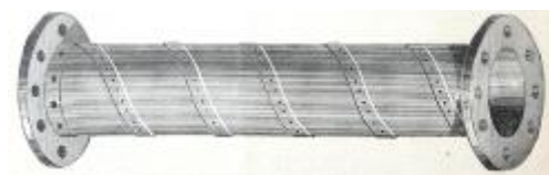
Niitattuja kierresaumaputkia tehtiin höyrylaitoksiin vielä 1990. (Am)
