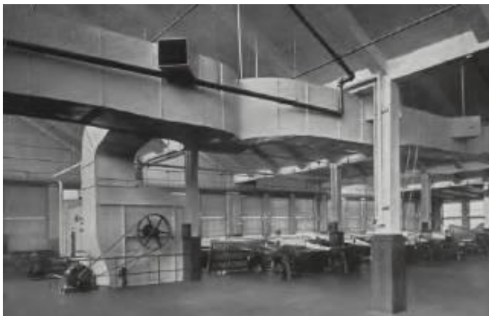
Teollisuuden ilmanvaihtolaitteet ovat olleet aika järeitä, mutta ratkaisut simppeleitä. Pääasia ilmanajossakin vuodelta 1915 näyttää olleen, että ilma lentää pitkälle. (Am)
