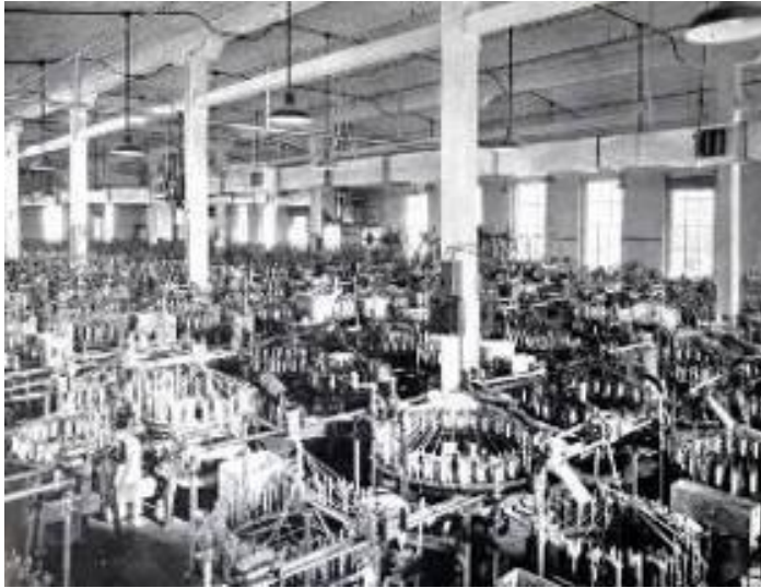
Erityisesti kehräämöissä hyvä kostutettu sisäilma on oleellista estämään pölyämistä ja kuitujen katkeamista., Kuva vuodelta 1920. (Am)
