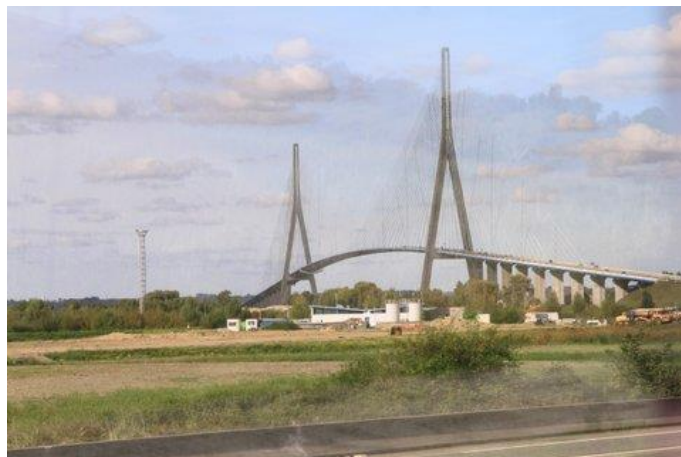
Pont de Normandie, vino köysisilta (kuv. Aslak Saviranta)
